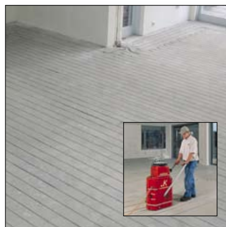
Woonkamer met ingeslepen verwarmingskabels van 3 mm. (inzet: stofvrij inslijpen met de gepatenteerde "Floorgrinder")
